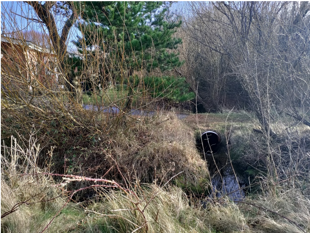
Billede 1-2 viser nærhed til vandløb ved Lyngbakken 9, ligeledes vises vandstanden i vandløbet (Tør vinterperiode 21-02-2023)
