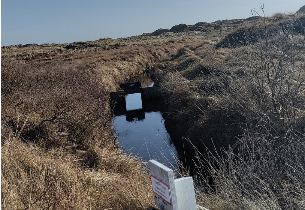
Billede 4-1 Stigbord for enden af Paradisvej, til at tilbageholde vandet i søerne i sommertiden, men som ligeledes tilbageholder vand i vinterperioden. (21-02-2023)
